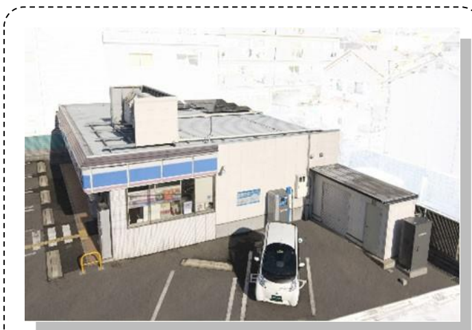
太陽能電池、鋰電池及快速充電機相結合的快速充電系統“PV-EV系統”。
